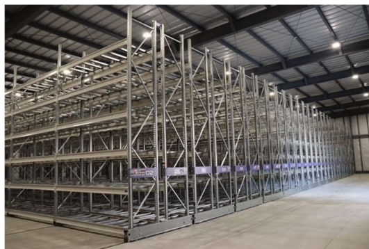
最大約 3,300 本を貯蔵する、移動式ラックシステムを備えた樽貯蔵庫
